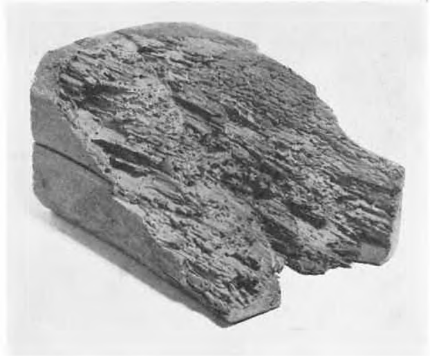
Abb. 8. Balkenabschnitt, von Anobien-Larven vollständig zerstört (Aufnahme: EMPA-C, St. Gallen)
