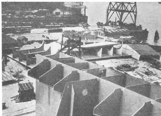
Abb. 2. Tankersektionen, vorgrundiert mit Epoxy/Zinkstaub-Grundierung
