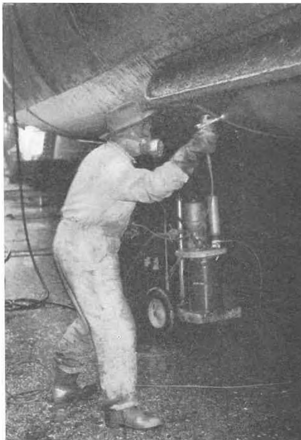
Abb. 3. Auftrag auf eine Schiffswand durch luftloses Spritzen
