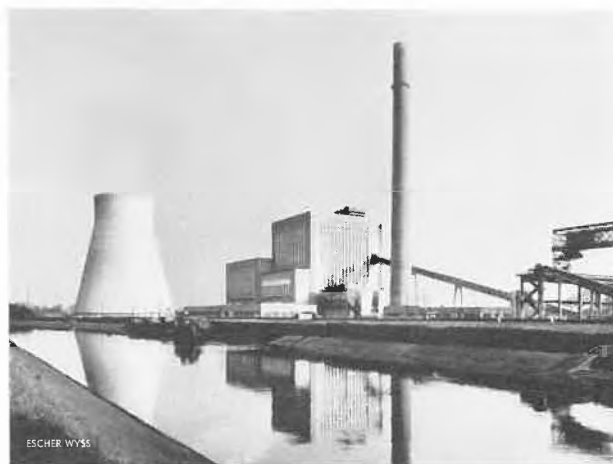
Abb. 28. Zentrale Baudour mit der in Abbildungen 26 und 27 gezeigten 115000-kW-Dampfturbine für 170 at 600°C
