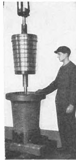
Abb. 23. Zusammenbau einer HD-Dampfturbine in sogenannter Topfbauweise. In vertikaler Lage wird der Rotor mit den darumgelegten Leiträdern in das einteilige Gehäuse geschoben
