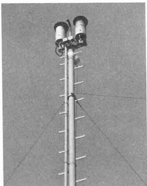
Abb. 6. Verbrennungsanlage für Giftgase. Letztere werden zuoberst in ferngezündete Ölflamme geleitet
