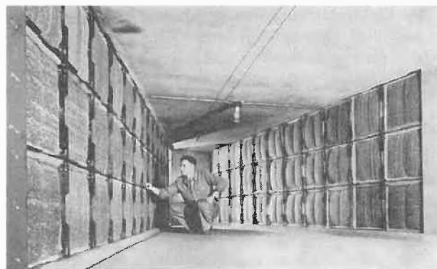
Abb. 1.3.11. Vorfilterwandanordnung
