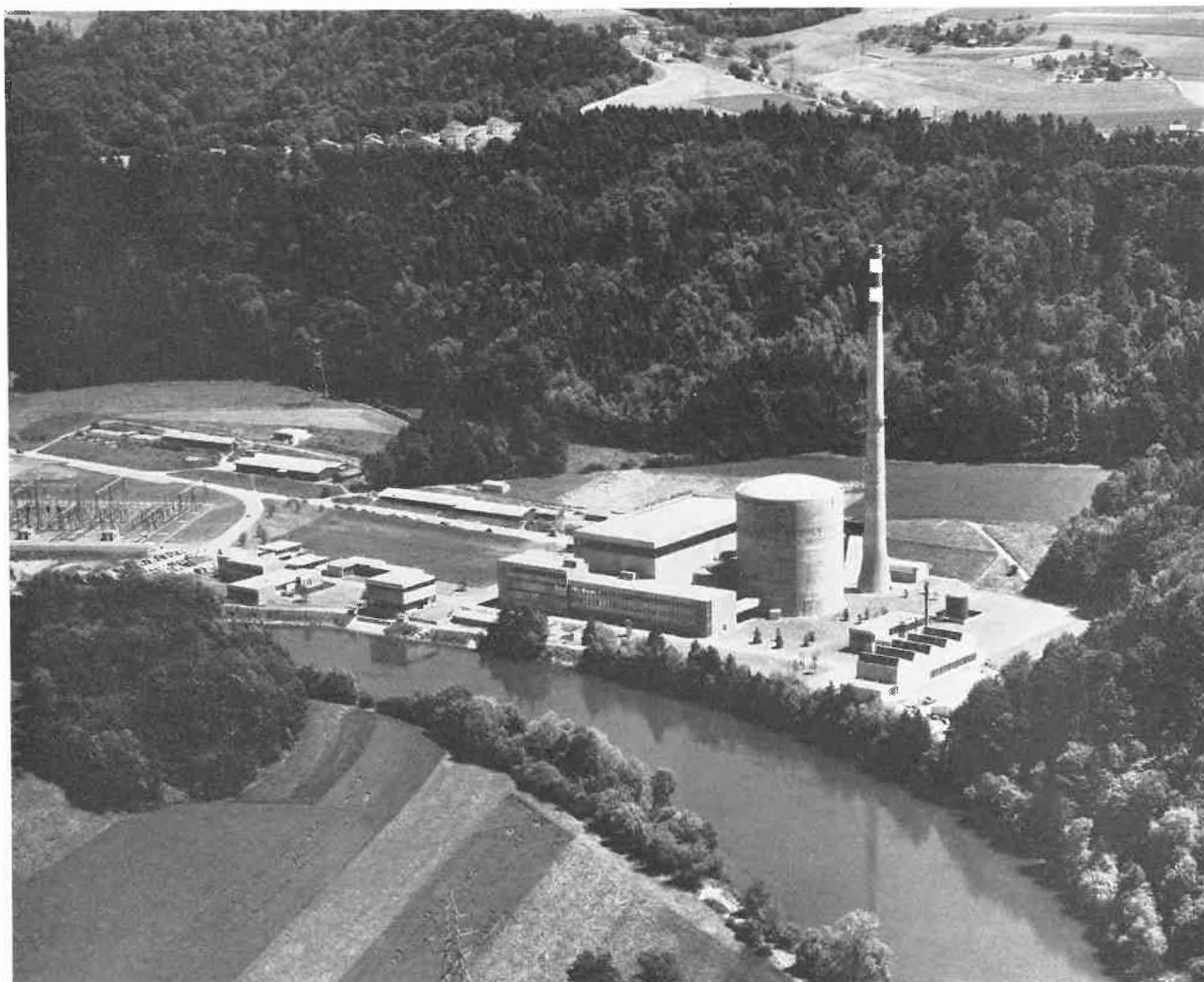
Kernkraftwerk Mühleberg. Die Flugaufnahme zeigt das in die Aarelandschaft eingebettete Werk. Es läßt die einzelnen Anlagen, wie auf dem Umschlagsbild, erkennen. Aufnahme: August 1972
