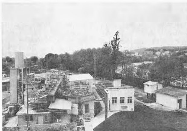
Abb. 1. Übersichtsbild über die technische Versuchsanlage. Links im Bild Abwasser-Verteilerturm; rechts davon (hintereinander) zwei Vorklär-Trichterbecken von je 12,5 m³ Inhalt; noch weiter nach rechts vier hintereinanderliegende Belebtschlammbecken; schließlich das in vier Sektoren unterteilte Nachklärbecken. Ganz rechts im Bild das System der 7 Testrinnen
