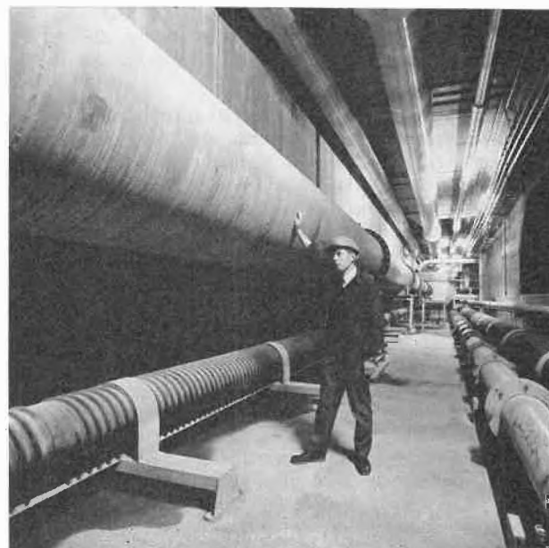
Abb. 4. Blick in den 530 m langen, voll begehbaren Kanalisations- und Energieleitungstunnel
