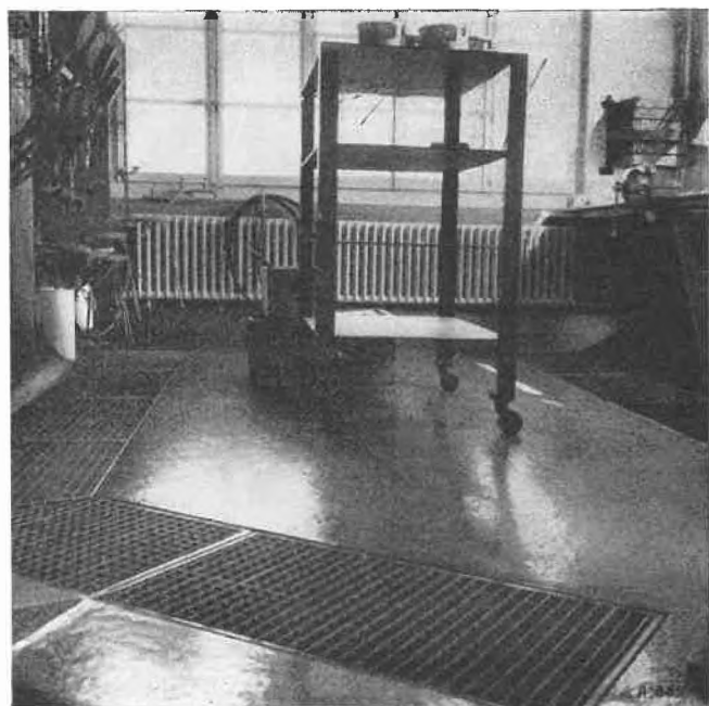
Abb. 5. Raum mit überdeckten Auffangkanälen
