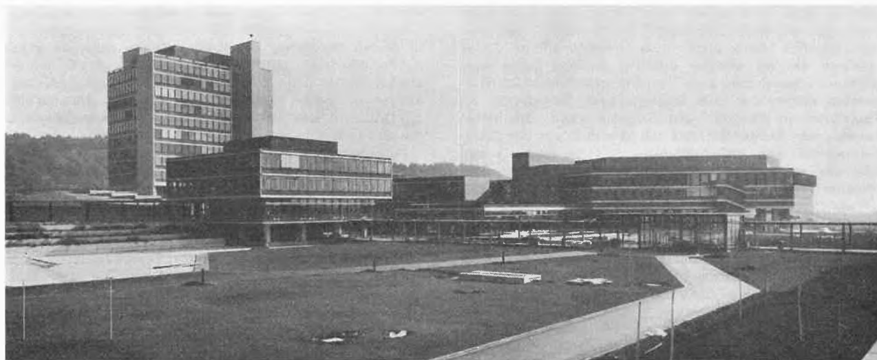
Beginn des Unterrichtsbetriebes der ETH Zürich auf dem Hönggerberg. Von links: Zehngeschossiges Praktikums- und davor Zentralgebäude (mit Bibliothek), das einstöckige Physikrestaurant mit 600 Plätzen; rechts das große sechseckige Hörsaalgebäude mit drei Hörsälen von zusammen rund 1200 Plätzen
