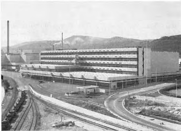
Gesamtansicht des Lagerzentrums Muttenz von Norden
