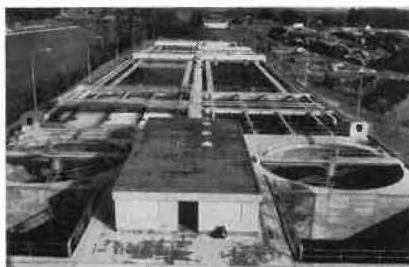
Anlageblock mit Betriebsgebäude der Biologischen Abwasserreinigungsanlage
