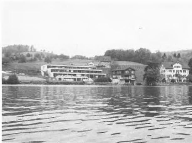
Seenforschungslaboratorium der EAWAG/ETH 1977 mit Neubau (links) «Hydrobiologischem Laboratorium» (Mitte) und «Seeheim» (rechts).
