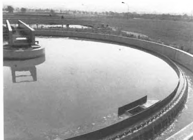
Abb. 4: ARA-Rhein: Kommunal-Anlage, Vorklärung.
