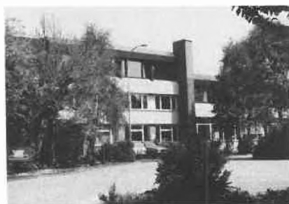
Abb. 2: Harmonisch gliedert sich das Verwaltungsgebäude der Firma Büchi AG an die angrenzende Wohnzone.
