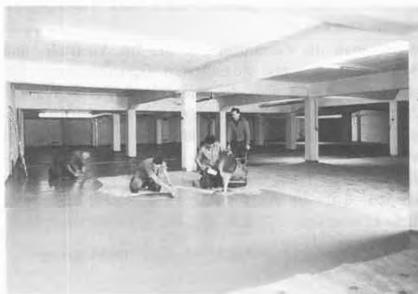
Abb.4: Verlegen eines selbstnivellierenden Bodenbelages auf Basis von Epikote-Harzen (Photo: Walo Bertschinger AG, Zürich)
