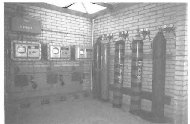
Abb. 13: Eine Messstation (3 IR-Analysatoren Lira 200 in Ex-Ausführung) mit ihren buntgefärbten Kalibriergas-Flaschen.
