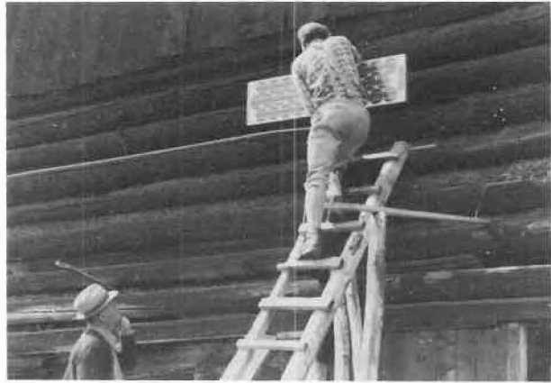
Abb. 2: Montage eines Kollektors mit \frac{1}{3} m 2 Siliziumzellen, 16,1 V – 2,05 A.
