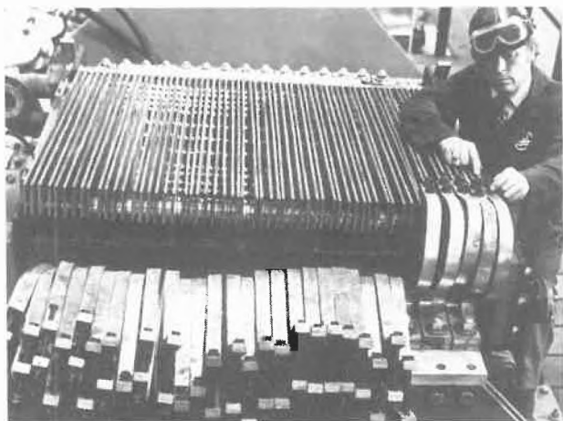
Abb. 2: Aufstellung und Zusammenbau einer Membranzelle des Typs FM21 vor Ort. Auf das Fehlen einer äusseren Rahmenkonstruktion wird besonders hingewiesen.
