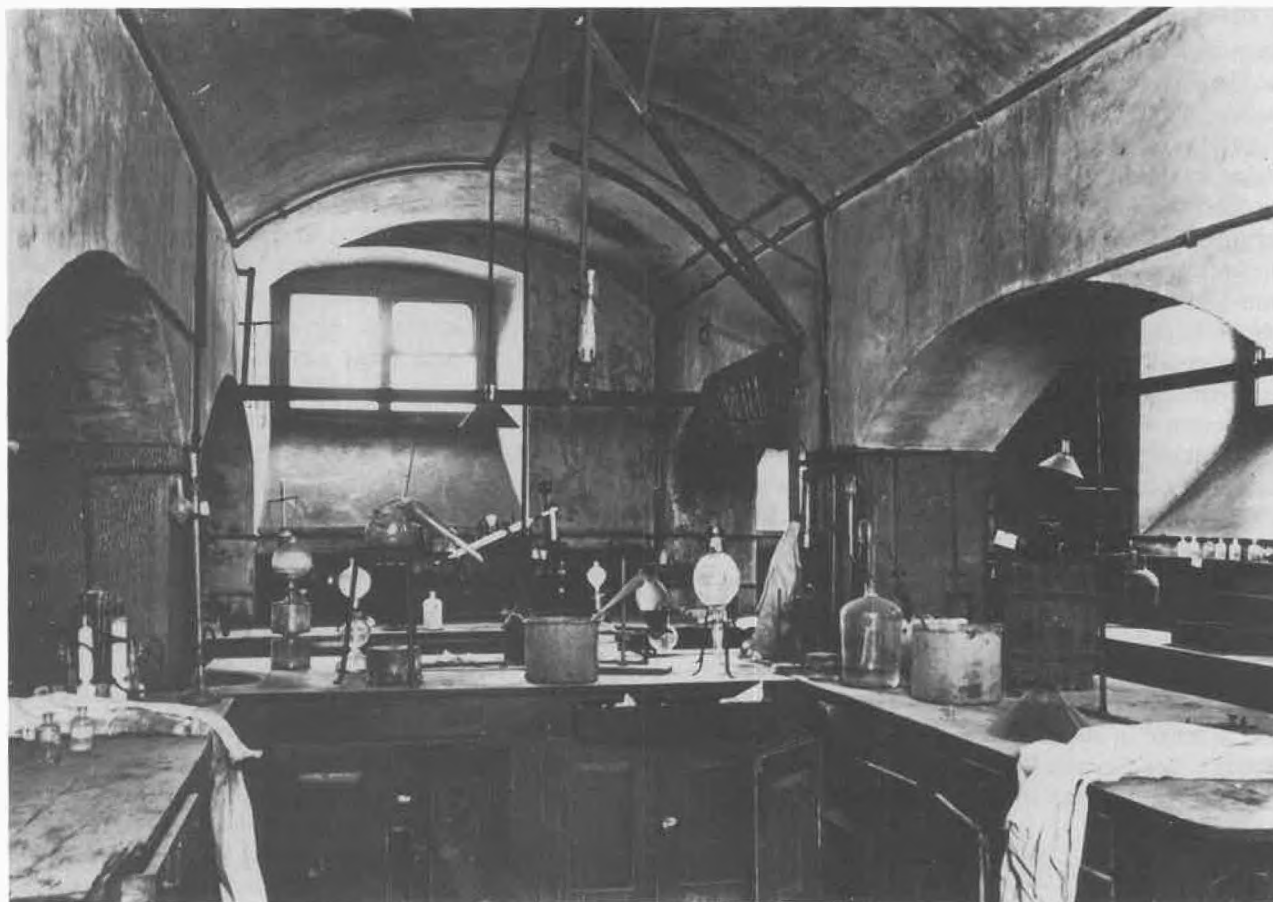
Abb. 7: Laboratorien im Keller von Rämistrasse 45 («Katakomben»)
