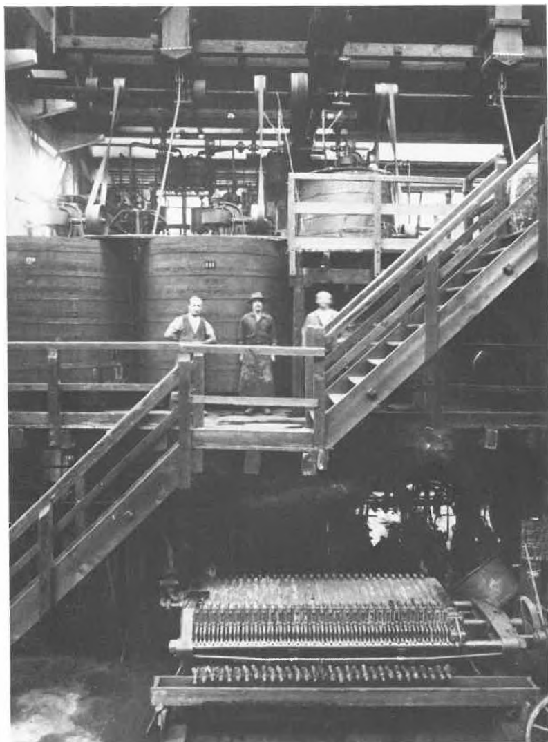
Fig. 1. Einst: Fabrikationsanlagen für Azofarbstoffproduktion im Jahre 1921. Die Beschickung der Kessel und die Prozessführung waren noch weitgehend Handarbeit. Mensch und Umgebung gerieten oft in Kontakt mit Chemikalien. Sicherheitsvorkehrungen wurden durch Personenschutz und Arbeitsvorschriften getroffen. Es war üblich, dass der Meister einen Hut als Statussymbol trug!
