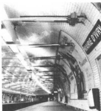
Polystal im Vergleich zu Stahlspanngliedern. Die Spannglieder liegen offen im Gewölbe knapp über der Oberkante der Metro-Züge. Sie sind im Schnitt 15 m lang und auf eine Zuglast von jeweils 650 kN vorgespannt.
