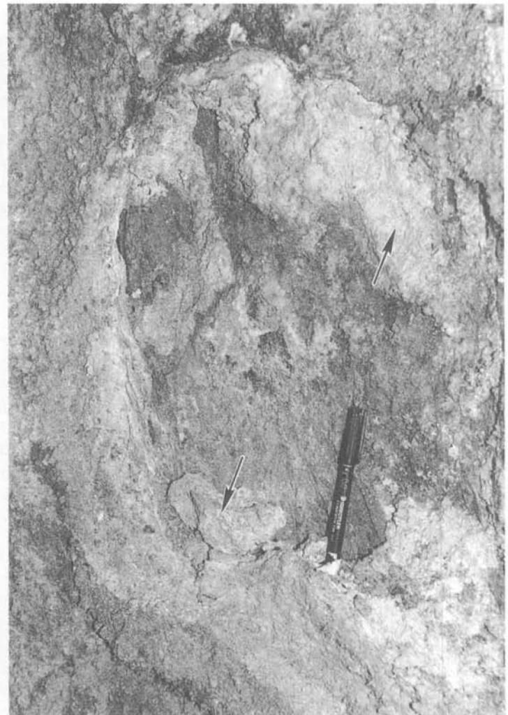
Fig. 3. Zu einer bräunlichen, knetbaren Masse umgewandelter Spritzbeton (Pfeilmarkierungen). Im zentralen Bereich der rundlichen Ablösung ist die Felsoberfläche sichtbar.
