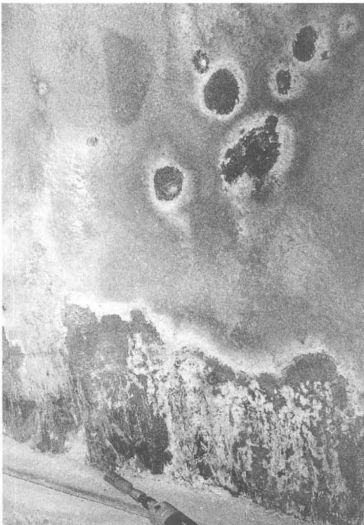
Fig. 2. Kristallisation und Anreicherung von Natriumsulfat und Natriumsulfat-Hydrat (weisse Krusten) auf Fels- und Spritzbetonoberflächen mit aufsteigender oder austretender Feuchtigkeit
