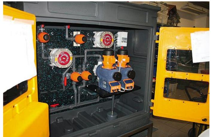
Abbildung 2: Dosierschrank für Aussenauflistung (Biogasanlage) mit zwei Dosagen inkl. Pulsationsdämpfern, zwei Druckhalteventilen und zwei Überströmventilen. (Quelle: UTEC Umwelttechnik GmbH)
